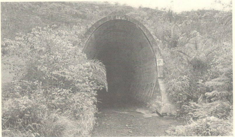
Figura 9a - Túneis e estruturas existentes desativados da ferrovia do Aço. Fonte: Estado de Minas, 20 mar. 2016.
